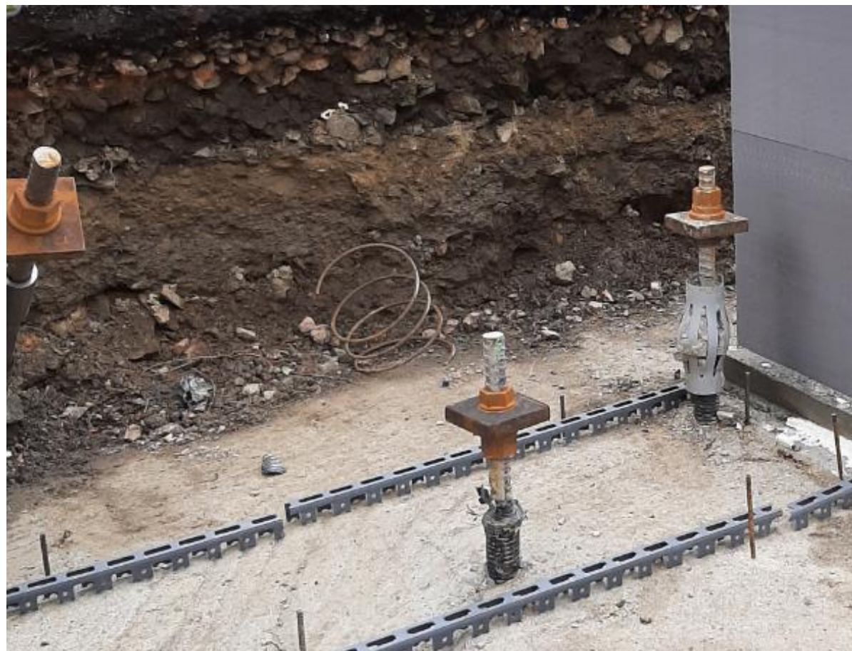
Typický systémový detail tyčovej mikropilóty
