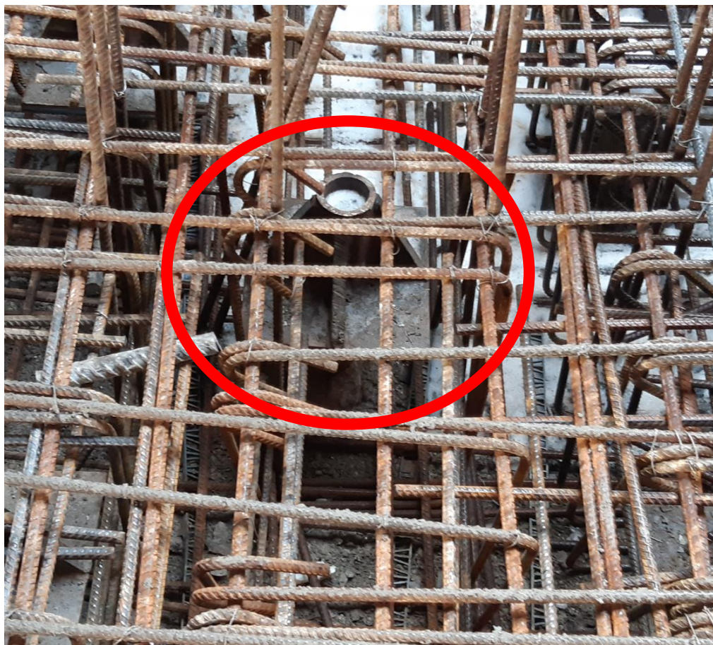
Typický detail hlavy mikropilóty CHS
